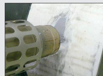
1. Místa vad očistit, části tovární izolace bez přilnavosti odříznout, hrany strazit na 30°. Tovární izolaci v oblasti opravy zdrsnit. Povrch musí být bez mastnot a nečistot
