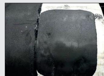
4. Tmelem PP-MELT-STICK vyplníme otvor v poškozené izolaci
